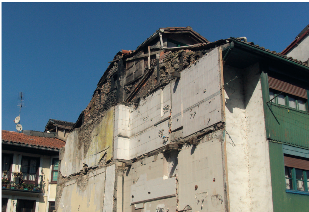
Eraitsi berria den tarte-hornen arteko eraikin baten irudia / Eraispen-lanen eta materialen arteko banaketaren zailtasuna agerian uzten du.
